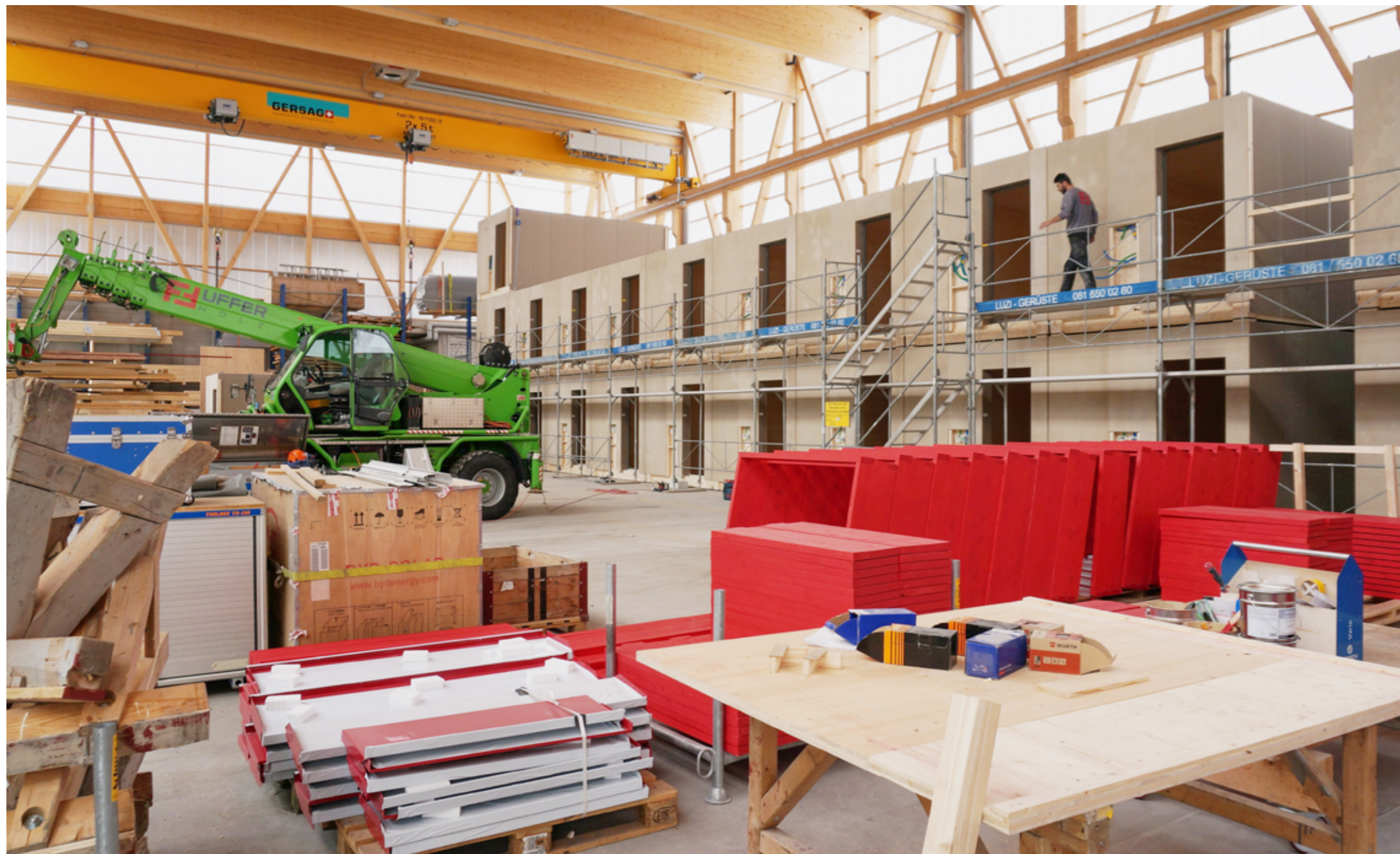
Die stapelbaren und selbsttragenden Wohnmodule werden bereits in der Fertigungshalle vollständig zusammengesetzt (oben) und betriebsbereit ausgebaut (rechts). Auf der Baustelle müssen diese dann nur noch zum dreistöckigen Konvikt-Provisorium aufgerichtet werden.
